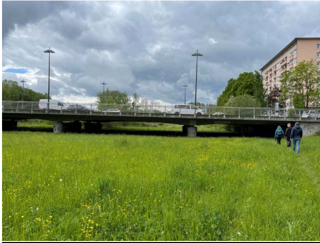
Abb. 8: Flutbrücke im Zuge der Hochstraße, Blickrichtung Süden
