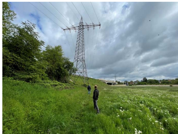
Abb. 3: Standort Mast 24, G305 am nördlichen Trassenbeginn
