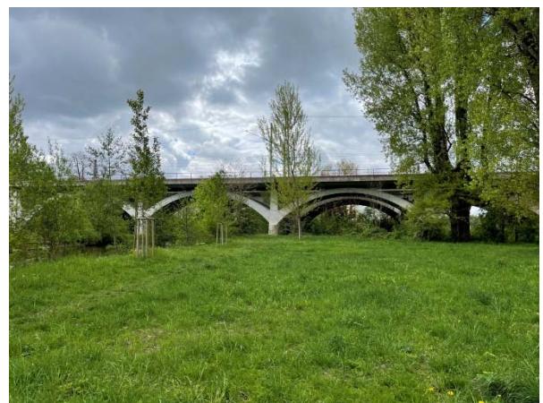
Abb. 13: Siebenbogenbrücke, Blickrichtung Süden
