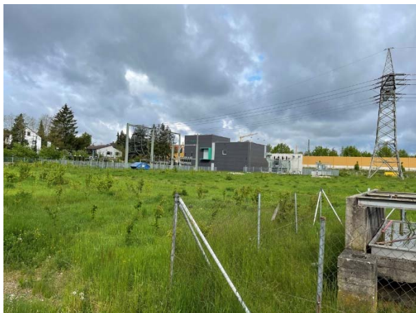
Abb. 2: Umspannwerk Vacher Straße am nördlichen Trassenbeginn
