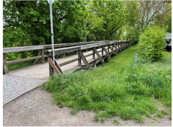
Abb. 9: Holzbrücke im Zuge des Hardstegs Blickrichtung Osten
